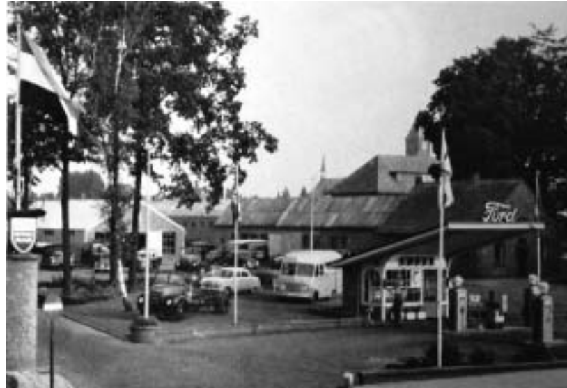
Achter de OBAM is de gestage uitbreiding van MCB zichtbaar: er wordt steeds iets aangebouwd. Aan de voorkant van het 'MCB-lint' het stenen kantoor-tje.
