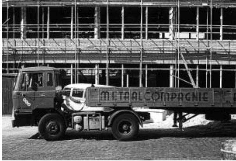
Het nieuwe kantoor in aanbouw.
