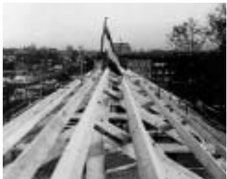
Het hoogste punt van het nieuwe kantoor.
