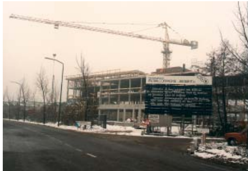
De bouw van het hoofdkantoor is onderweg.
