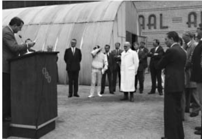
De plechtigheid waarbij de Valkenswaardse burgemeester Bartels (witte jas) de eerste paal slaat van het kantoorgebouw in Valkenswaard.
