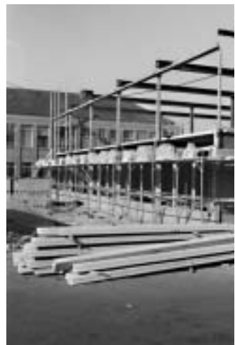
Uitbreiding van de kantoorruimte.
