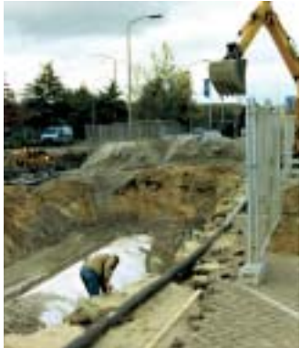
Er wordt een nieuwe tankinstallatie aangelegd.
