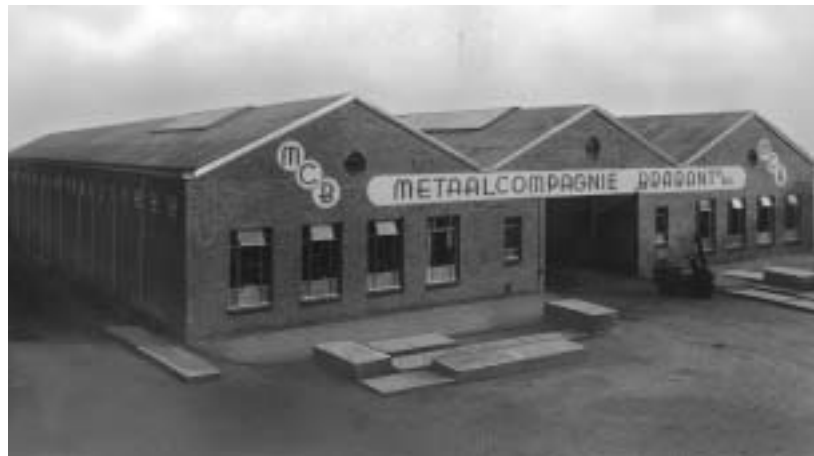
Het nieuwe magazijn bestaat uit drie hallen en draagt de bedrijfsnaam over de gehele breedte.
