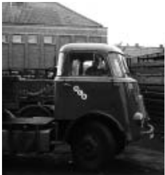
Loswerk kan meestal niet op het terrein plaatsvinden en zorgt dus voor een heleboel gemier op de Aalsterweg. En tel daar de slecht startende vrachtwagenmotoren nog maar bij. Het is geen pretje voor de omwonenden.
