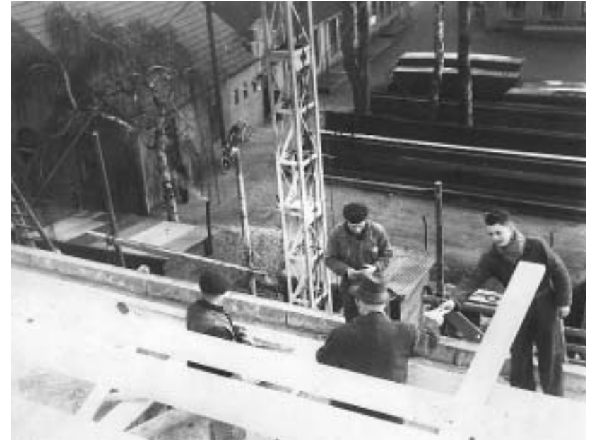
Het hoogste punt van de bouw is bereikt: Marinus van Kempen, die met veel toegestoken handen op de bouwsteiger wordt geholpen, deelt een extraatje uit aan de bouwvakkers. Naar beneden via de ladder blijkt even later nog veel enger!
