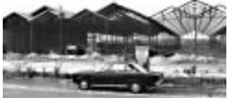
In Valkenswaard zijn vijf nieuwe hallen aan het 'groeien'.
